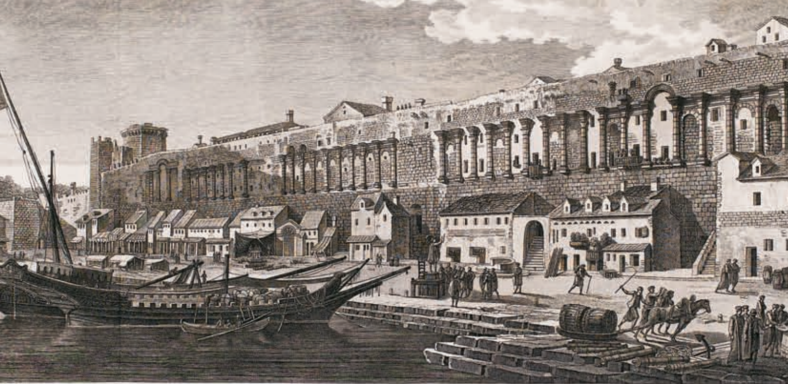
VUE GÉNÉRALE DU PALAIS DE DIOCLETIEN, Vue du côté de la grande Colonnade et du Port
