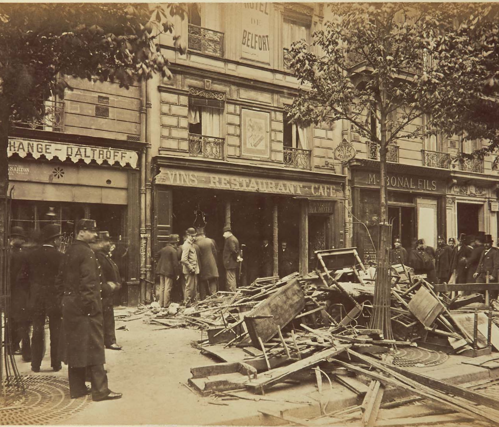
Explosion du Restaurant Véry Vue extérieure du restaurant. Vue prise sur la droite
