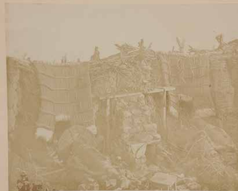
Intérieur de la Batterie des Casernes à Sebastopol.
