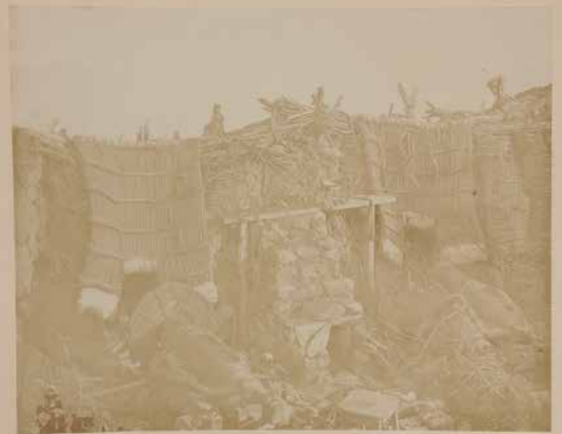
Intérieur de la Batterie des Casernes à Sebastopol.
