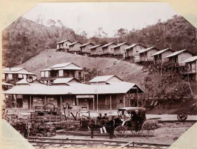
Canal de Panama Habitations ouvrières
